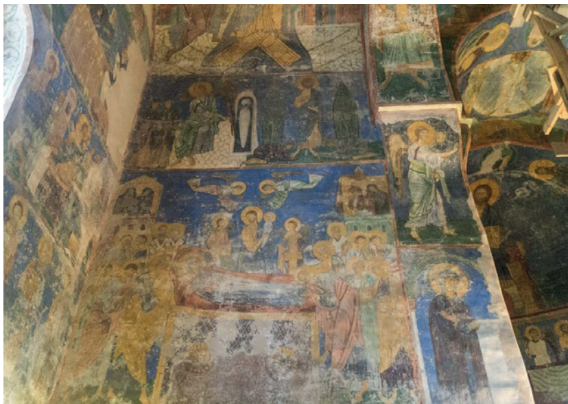
Восточная часть северной ветви подкупольного креста. Общий вид The eastern part of the northern branch of the domed cross. A general view
